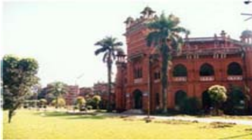
ダッカ大学の教育・研究棟の1棟
